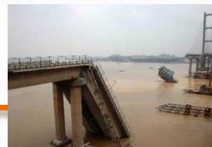
九江大桥船撞桥断事故 2007年5月15日
