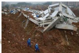
深圳光明新区渣土受纳场重大滑坡 2015年12月20日
